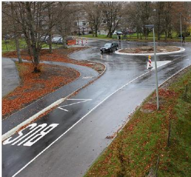
Weniger als zwei Monate benötigte die Baumaßnahme.
